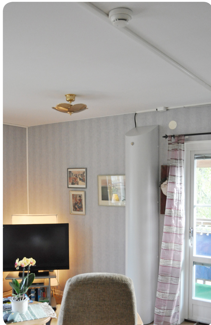
En mobil sprinkler installerad på väggen i vardagsrummet.
