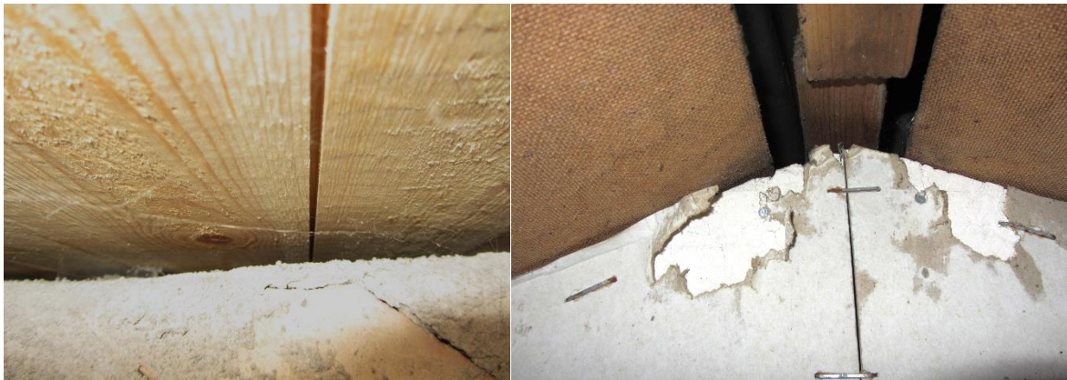
Figur 4. Exempel på otät anslutning mellan skiljevägg på vind och yttertaketets undersida.
