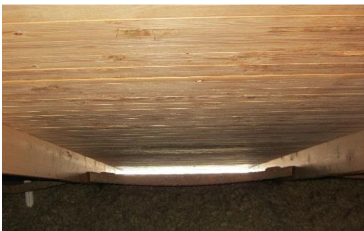
Figur 10. Öppen takfot, sedd från insidan av vinden.
