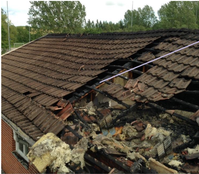
Figur 5. Synlig glipa som bildats över brandcellsgränsen när masonitskivan i yttertaketets undersida har brunnit bort.
