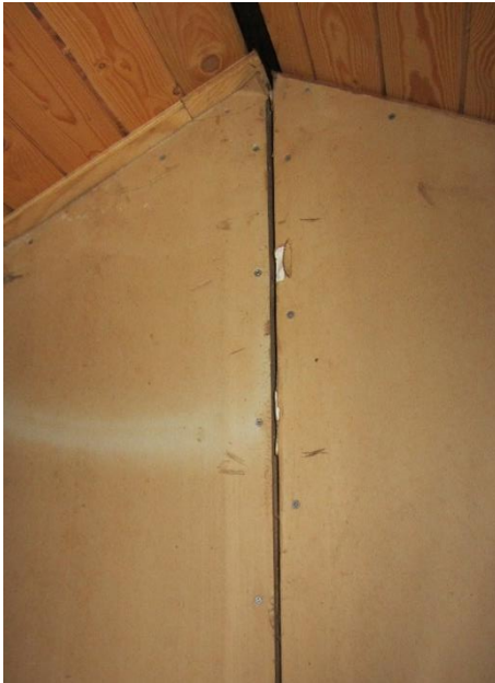
Figur 7. Exempel på otät skiljevägg med tydlig springa mellan gipsskivorna.
