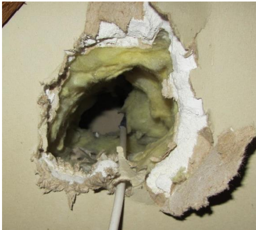
Figur 8. Exempel på otäta genomföringar.
