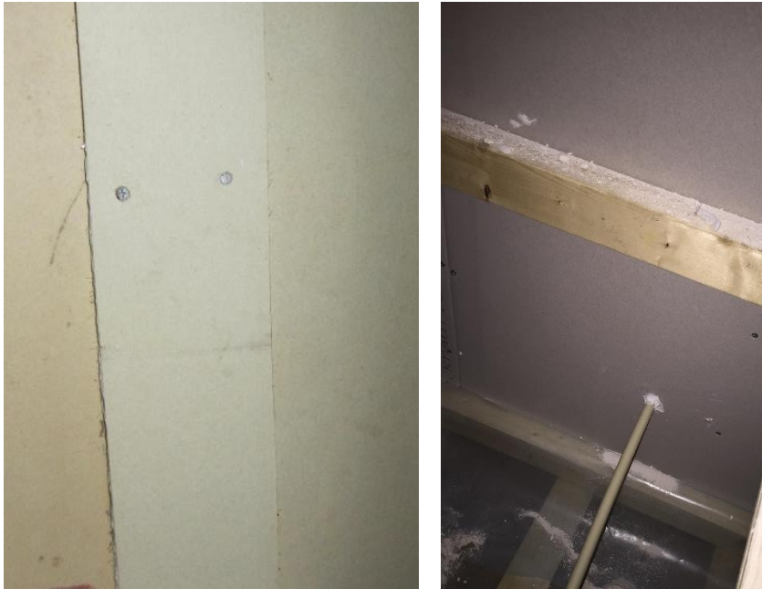
Figur 9. Princip för hur en gipsskiva kan monteras över otätbet i en skiljevägg samt hur en genomföring kan brandtätas.
